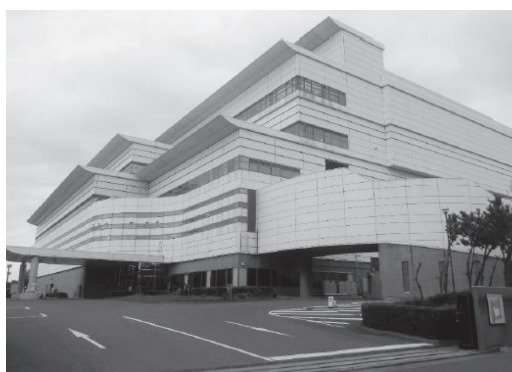
写真1 新港清掃工場
